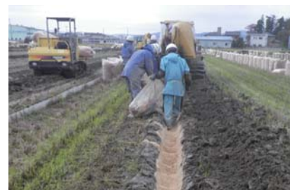
暗渠排水の施工状況
